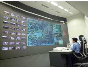
A 交通管制センターでは、道路の渋滞状況や交通事故などの渋滞の原因となる情報を集め、コンピューターで処理することで、車の流れが良くなるように信号機の時間の調整をしたり、交通情報板などで交通渋滞の様子をドライバーに知らせたりしています。
